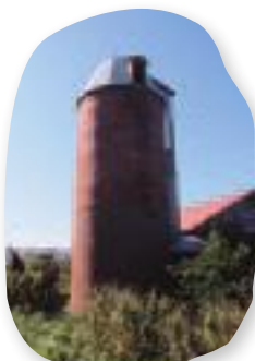
●現存する北海道最古の レンガサイロ 三澤牧場のレンガサイロは、 1921(大正10)年に建てら れた。八雲町には、多くのレン ガサイロや牛舎が残っている
