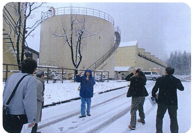
秋田県湯沢市 東北電力「上の岱発電所」
