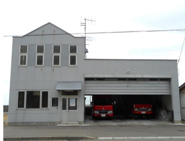
■熊石消防署相沼泊川分遣所
