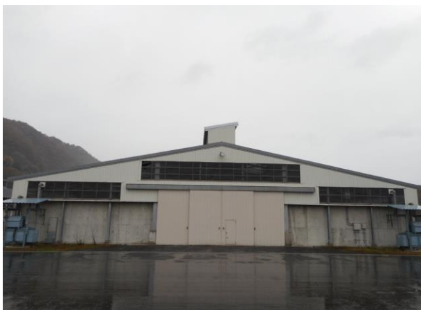
■八雲町地域バイオマス利活用施設
