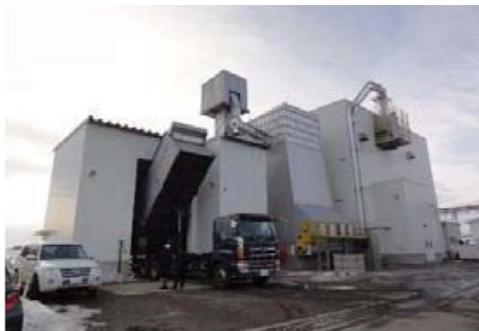
▲木質バイオマスボイラー棟
