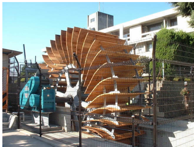
図 3-1 1 家中川小水力市民発電所（最大出力 20kW）
