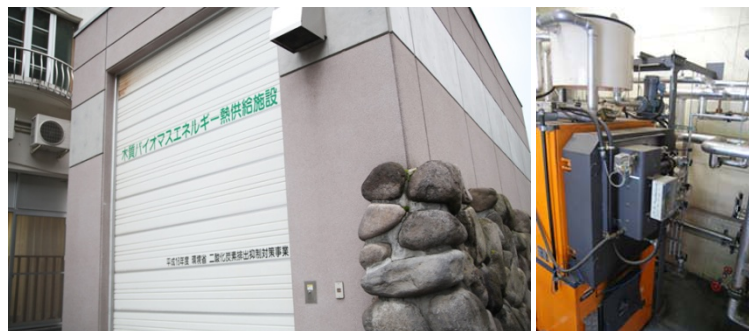
図 3-1 6 下川町五味温泉（木質チップ燃料活用 180kW 暖房・給湯・温泉加温）
