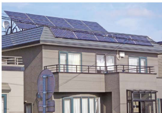
図 3-7 住宅用太陽光発電の例
