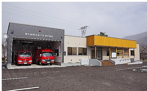
熊石消防署相沼・泊川分遣所
