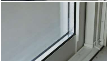
全住戸で外窓交換を実施
