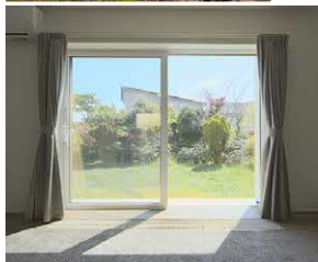
外窓交換(はつり工法)を実施
