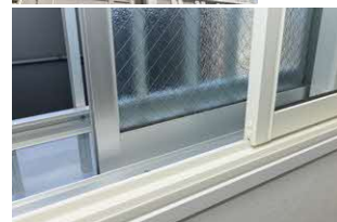
全住戸の内窓設置を実施
