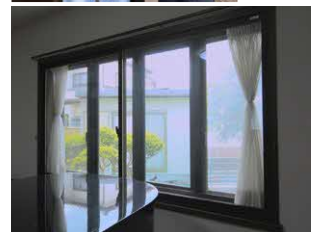
内窓設置を実施
