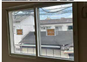
主居室の南側に内窓設置
