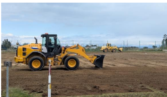
河井工業の皆様が重機でグラウンドを整備する様子です
