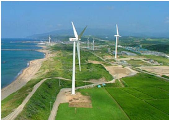
瀬棚臨海風力発電所(12,000kW(出力2,000kW×6基))
