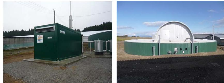
八雲町家畜糞尿バイオガス発電(右:発電機、左:発酵槽)
